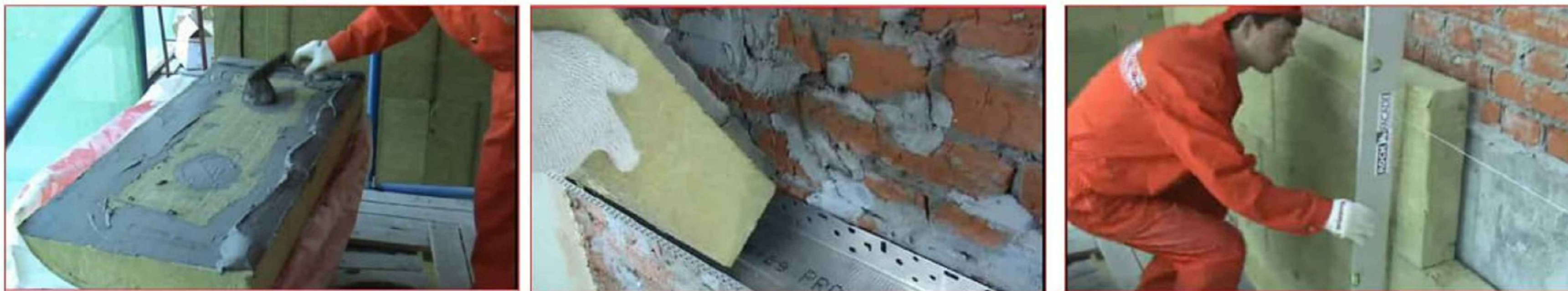
4.Иесиклик химоя қатлами базальт толали минерал плиталарни маҳкамлаш ва елимли сувоқ ишлари.
