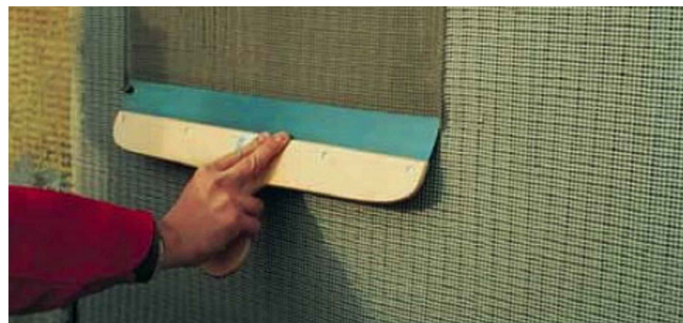
Устройство штукатурки из клеевого раствора с щелочестойкой сеткой
