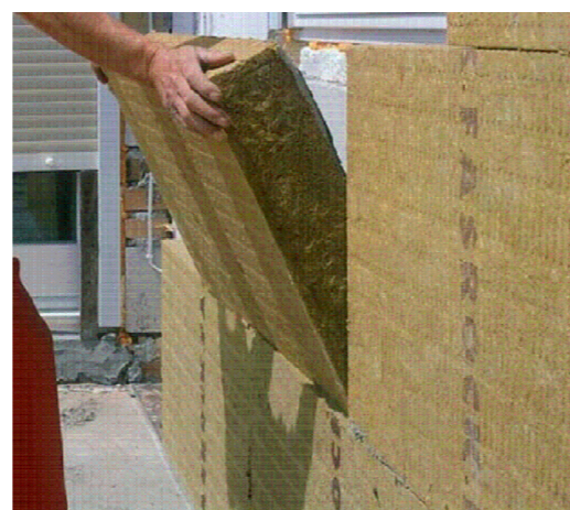
Монтаж плит утеплителей.
